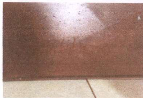
Foto. 6 Remodelación de puertas aula No. 1
