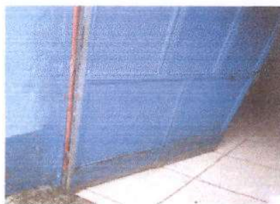
Foto. 5 Remodelación de puertas aula No. 2
