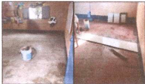
Foto. 1 Piso en Remodelación aula No. 1 Módulo 2
