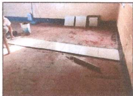
Foto. 3 Remodelación de piso número 2 Módulo 2
