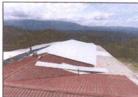
Foto. 4 Remodelación de techo número 2 Módulo 1
